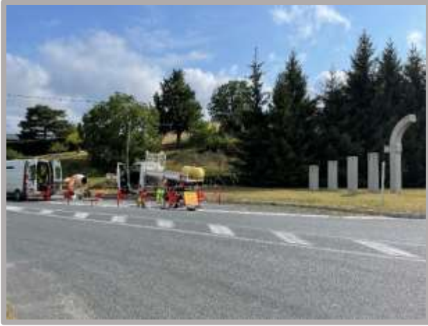
Réparation des bordures.
