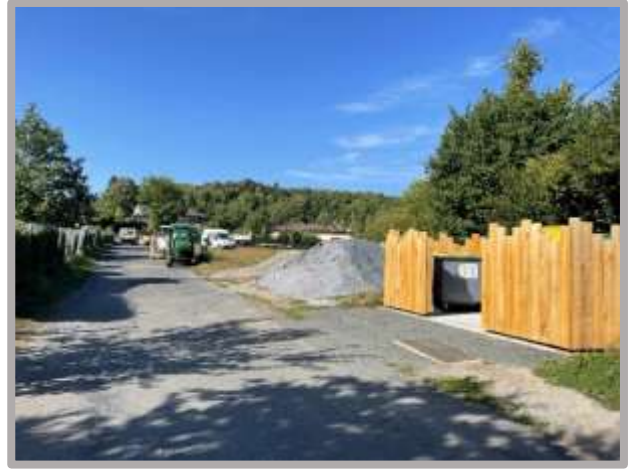
Création de l'abri en bois autour des poubelles de Bel-Air.
