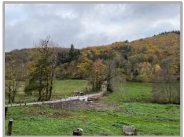
Nouveau pont à Lavergne
