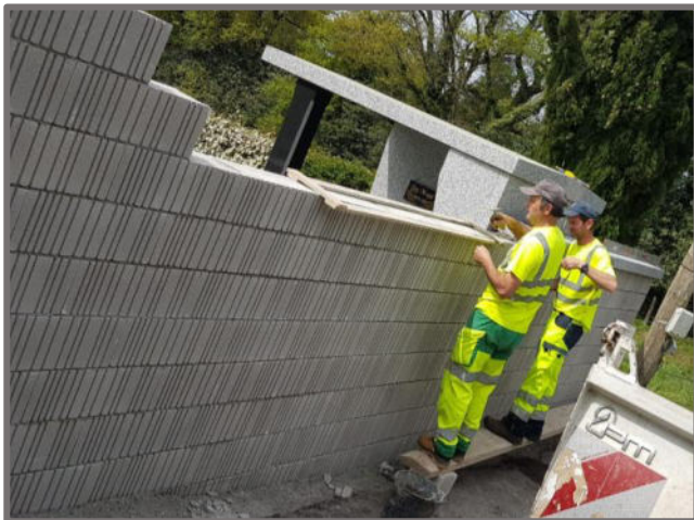
Réfection du mur au cimetière du Bez en blocs décoratifs.
