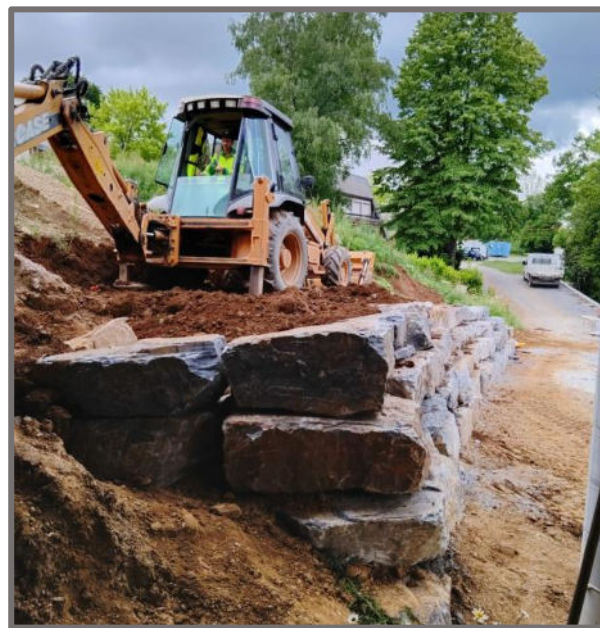
Construction d'un mur de soutènement du talus au niveau du stationnement près de l'agrandissement de l'école.
