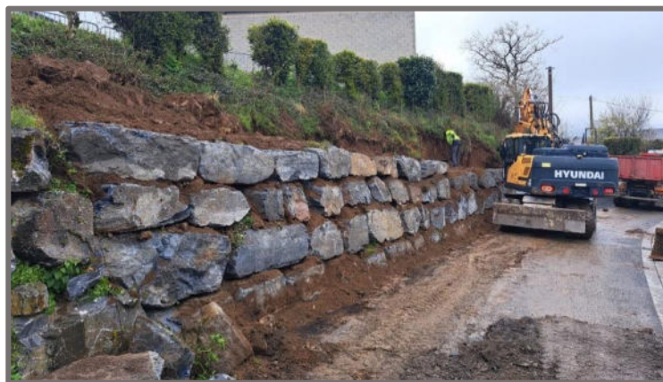
Chemin des Cabanes. À la suite des fortes pluies du printemps, des travaux ont dû être réalisés sous le parking de la mairie afin de sécuriser le terrain. Un mur de soutènement a été construit pour renforcer la stabilité du talus et prévenir tout risque d'affaissement.
