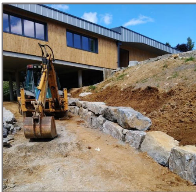
Construction d'un mur de soutènement du talus au niveau du stationnement près de l'agrandissement de l'école.
